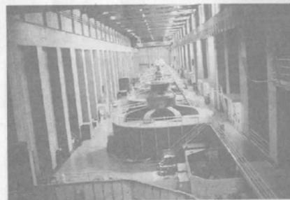
まん中の写真の左側に見える発電施設の内部。17台の発電機により192万キロワットの発電能力がある。世界最大級の水力発電施設。
