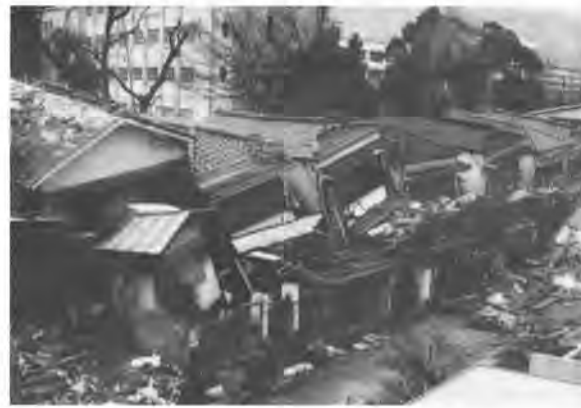
「震災直後の倒壊した家屋」
